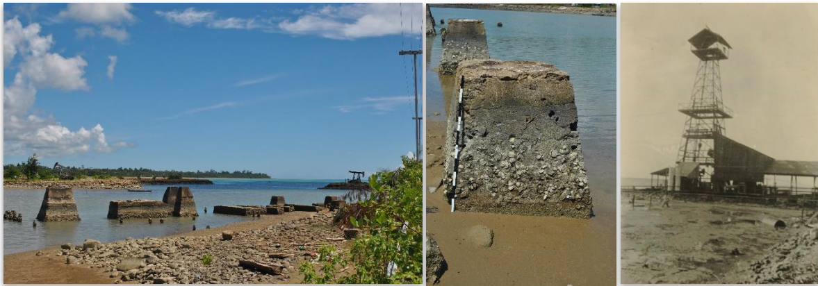
Gambar 7 dan 8. Bekas pondasi menara pompa di Bula Lemon. (Sumber. Dokumentasi Balar Maluku, Tahun 2016).
