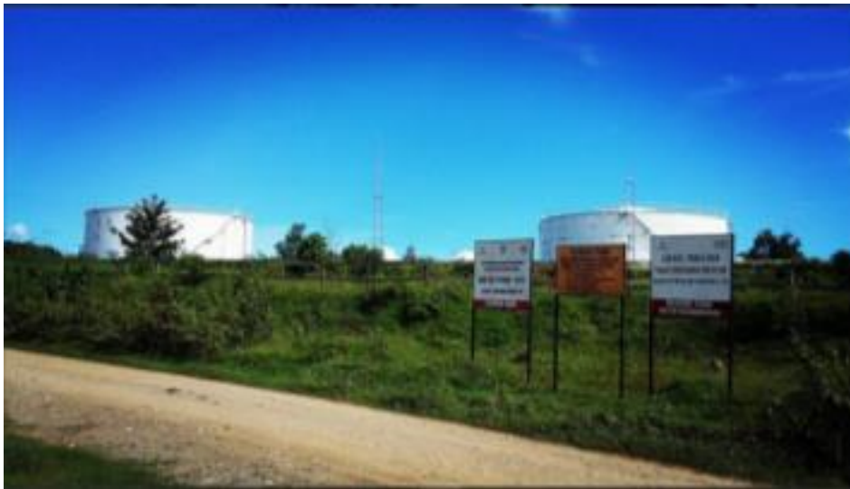
Gambar 2. Main Oil Storage (MOS) di kawasan PT. Kalrez (Seram) Ltd. (Sumber: Dokumentasi Balar Maluku, Tahun 2016)
