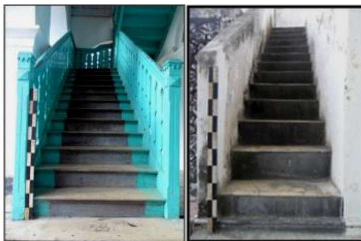
Gambar 4. Tangga depan dari kayu dan tangga belakang dari konstruksi beton masif (Sumber: Hasrianti, 2013)
