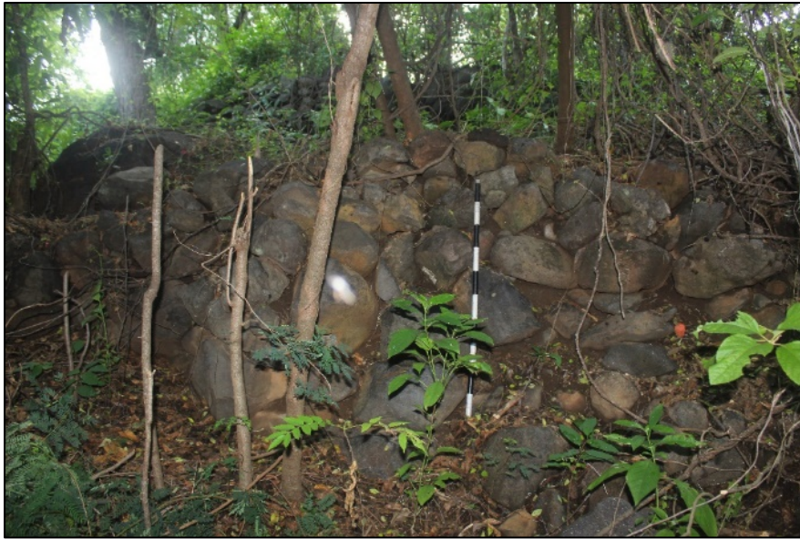
Gambar 4. Kondisi Struktur Pondasi di Situs Tanjung Leworaja (Sumber: Hamado, 2023)
